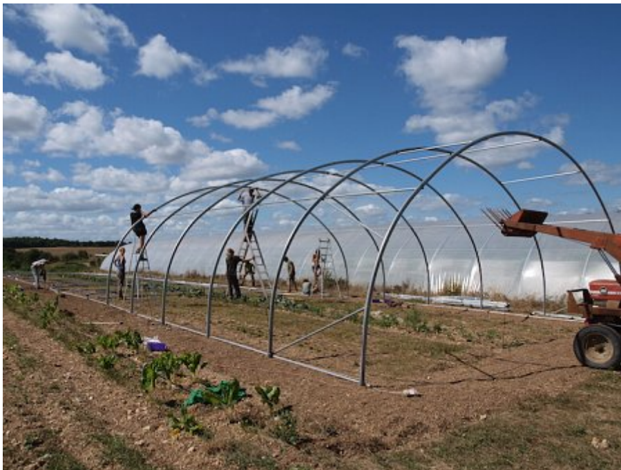
Installation des serres pour le maraîchage.
