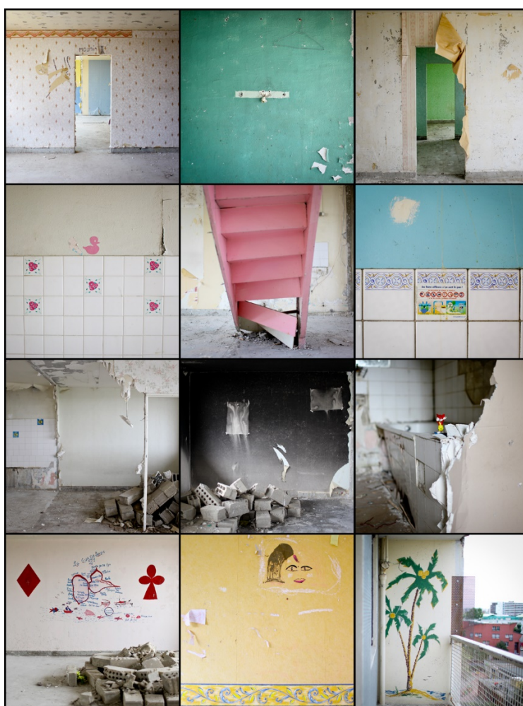
Dans la barre Balzac, été 2011, pendant la destruction. © E.R
